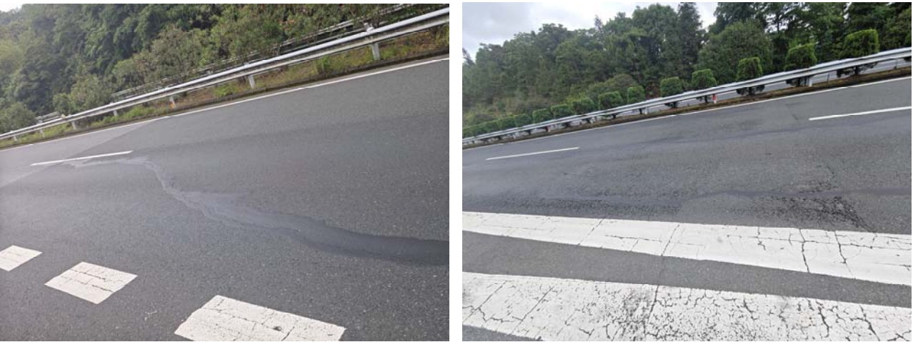
图 4-2 纵向裂缝
