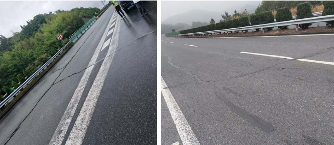
图 4-1 横向裂缝
