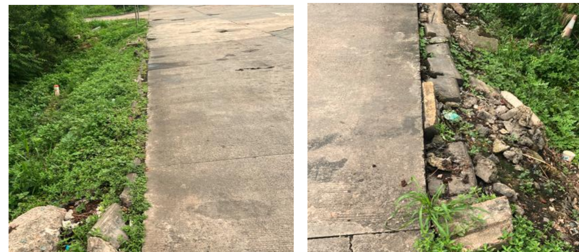
定南服务区破损的路缘石
