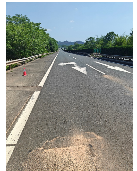
涵洞顶面路面现状
