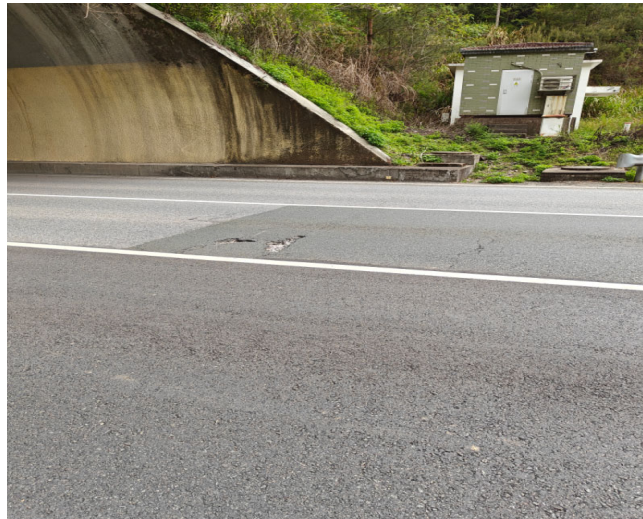
路面整体现状
