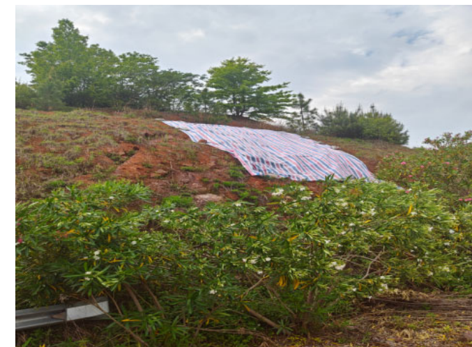
边坡整体现状
