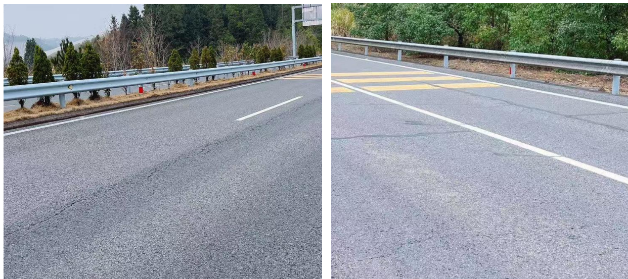
图 4-1：裂缝
