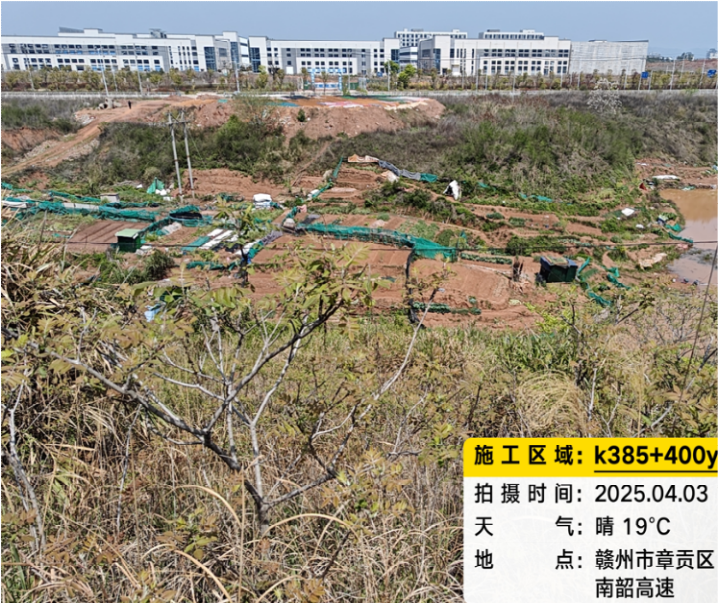
K385+300~K385+420 左侧路堤边坡
