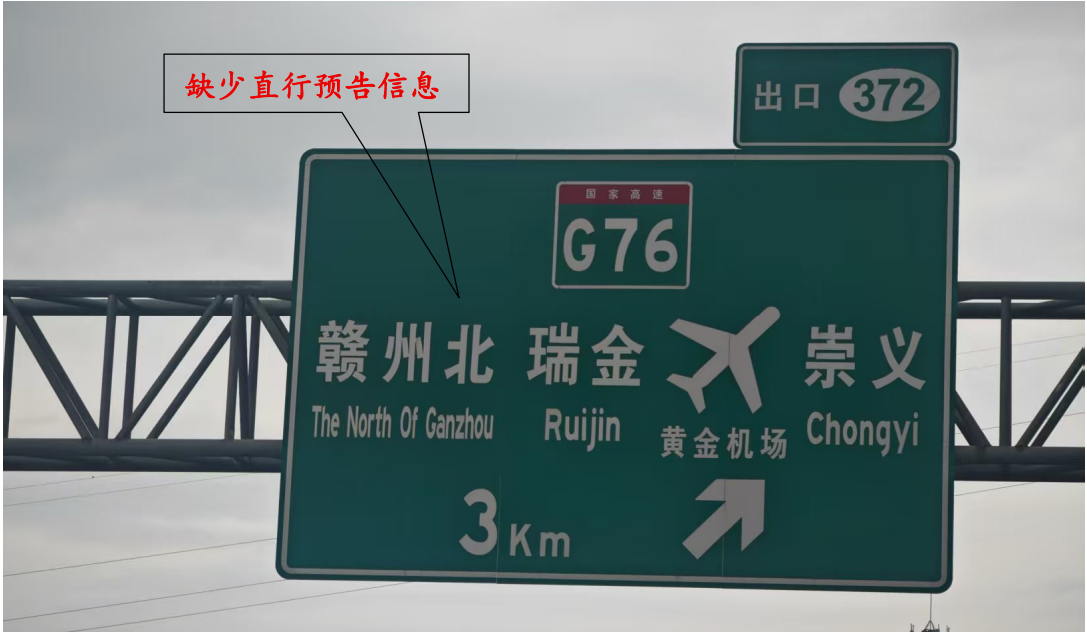
图10 兴赣高速（兴国王赣州方向）3km处预告标志现状图
