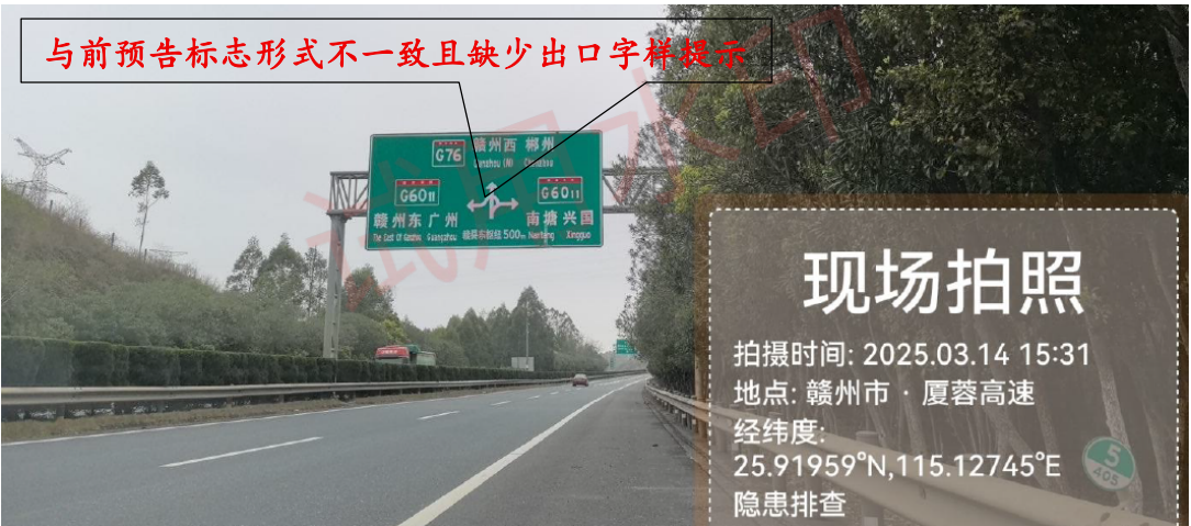
图6 北线距离枢纽500m处预告标志现状图
