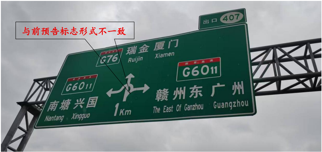
图9 南线距离枢纽1km处预告标志现状图
