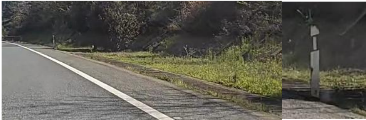
轮廓标损坏锈蚀或缺失
