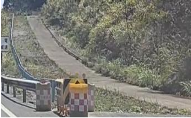
原有避险车道坡床集料流失，末端无防护
