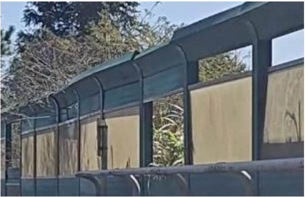
部分路段声屏障脱落损坏
