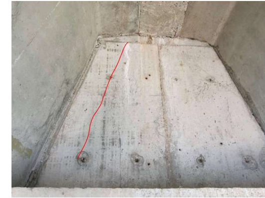
图 3.2.10 湿接缝渗水结晶
