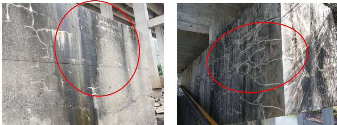
图 3.3.2 桥墩裂缝
