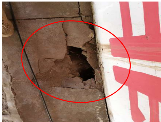
图 3.3.5 桥台空洞
