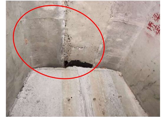
图 3.2.11 横隔板空洞
