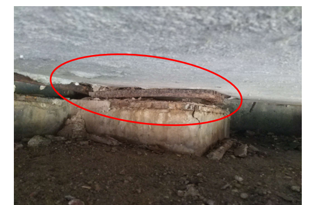
图 3.2.15 钢垫板锈蚀
