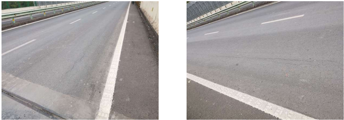
图 3.2.16 桥面裂缝
