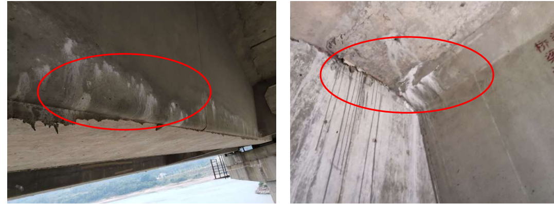
图 3.2.6 主梁渗水结晶
