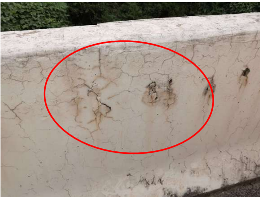
图 3.2.1 护栏露筋
