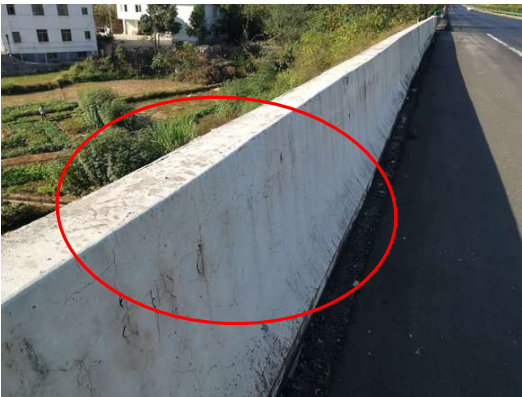
图 3.2.2 金属横梁缺失
