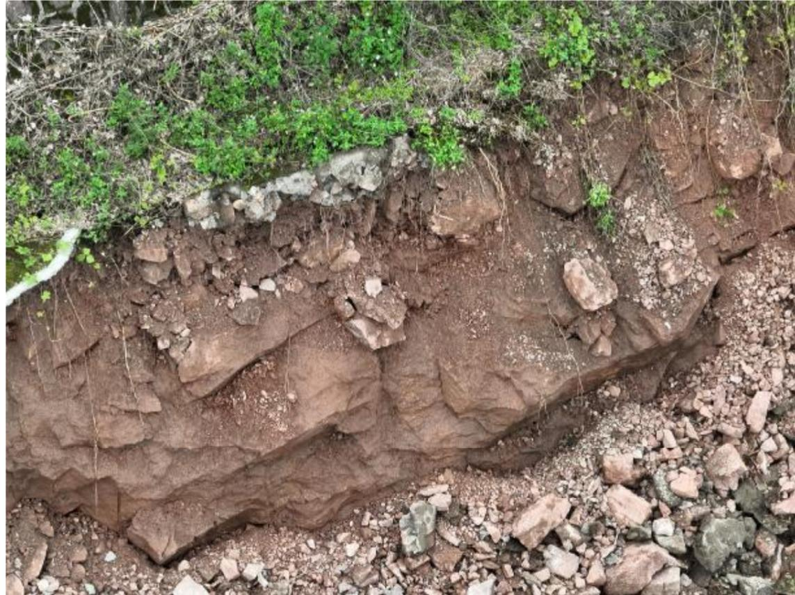
坡面揭露红砂岩局部松动裂隙发育
