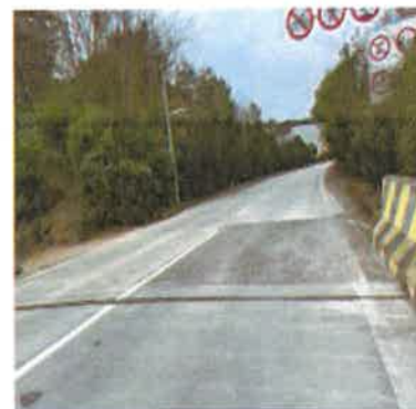
图6 边缘线磨损严重
