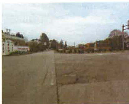
图2 平交口破碎、露骨
