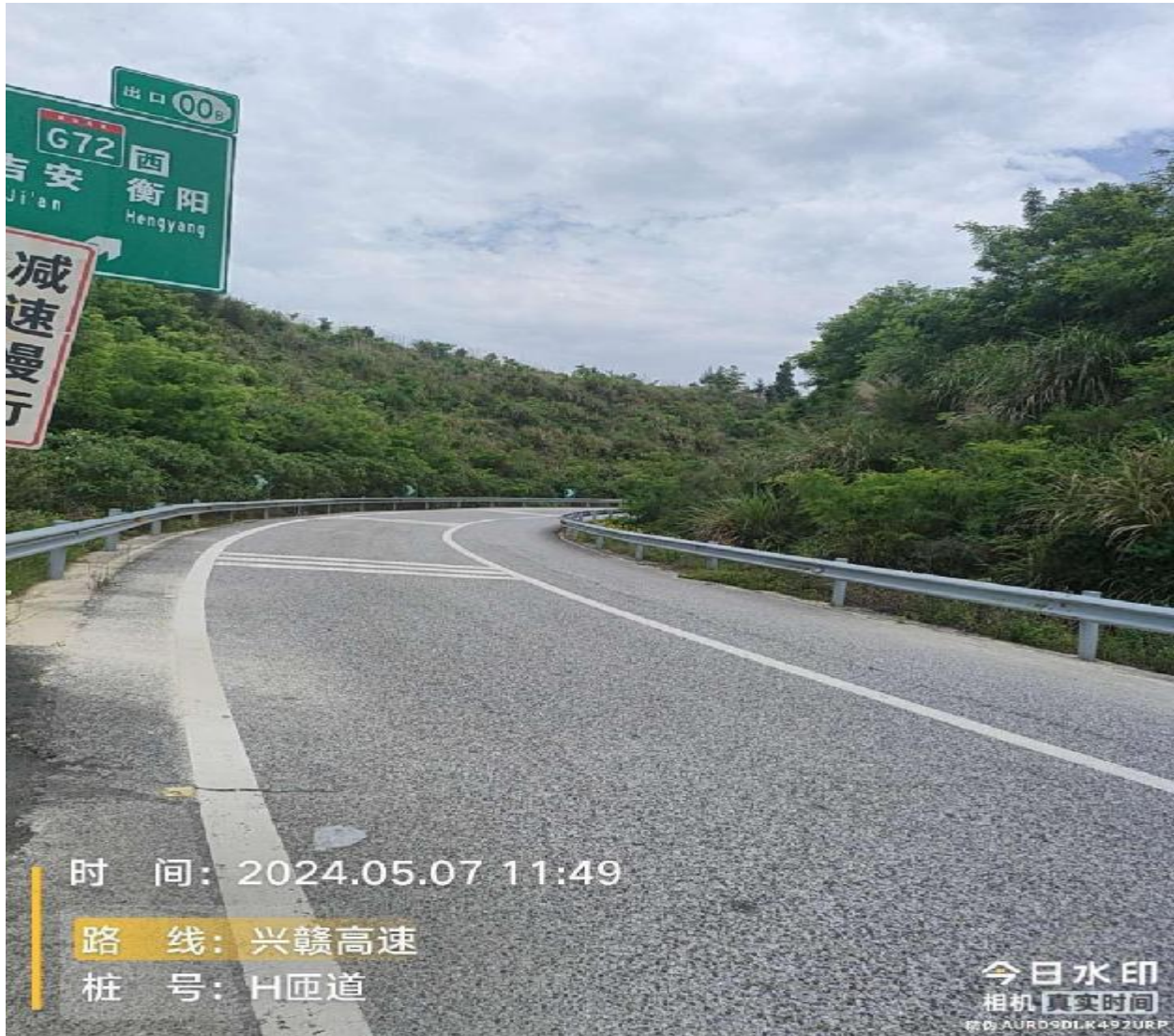
边坡整体现状
