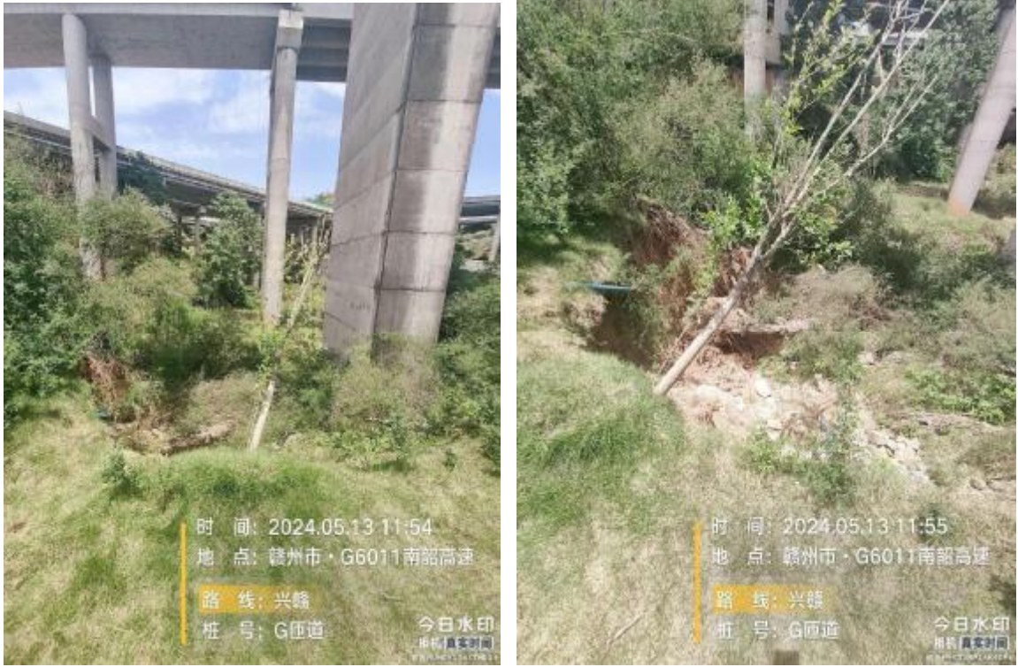
边坡整体现状
