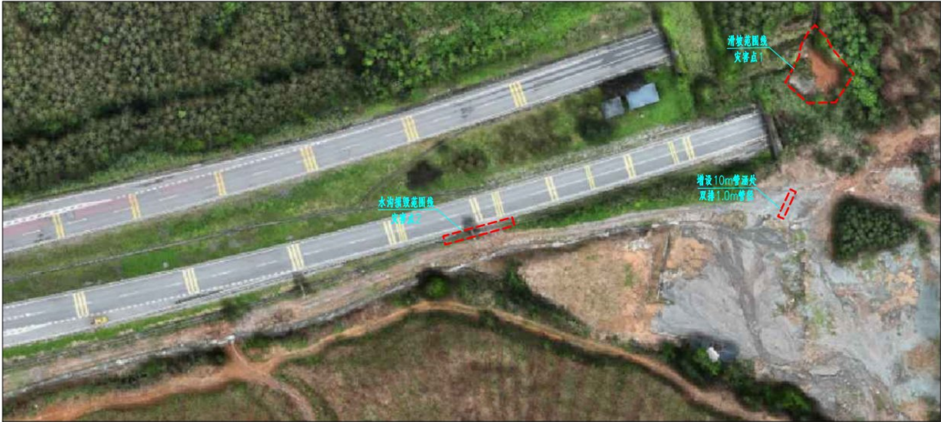
K97+000右幅松虎坑3号隧道处灾害平面图
