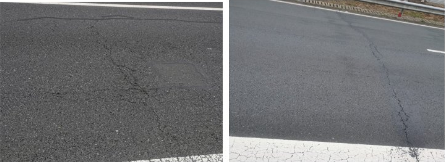
图 4-1：横向裂缝
