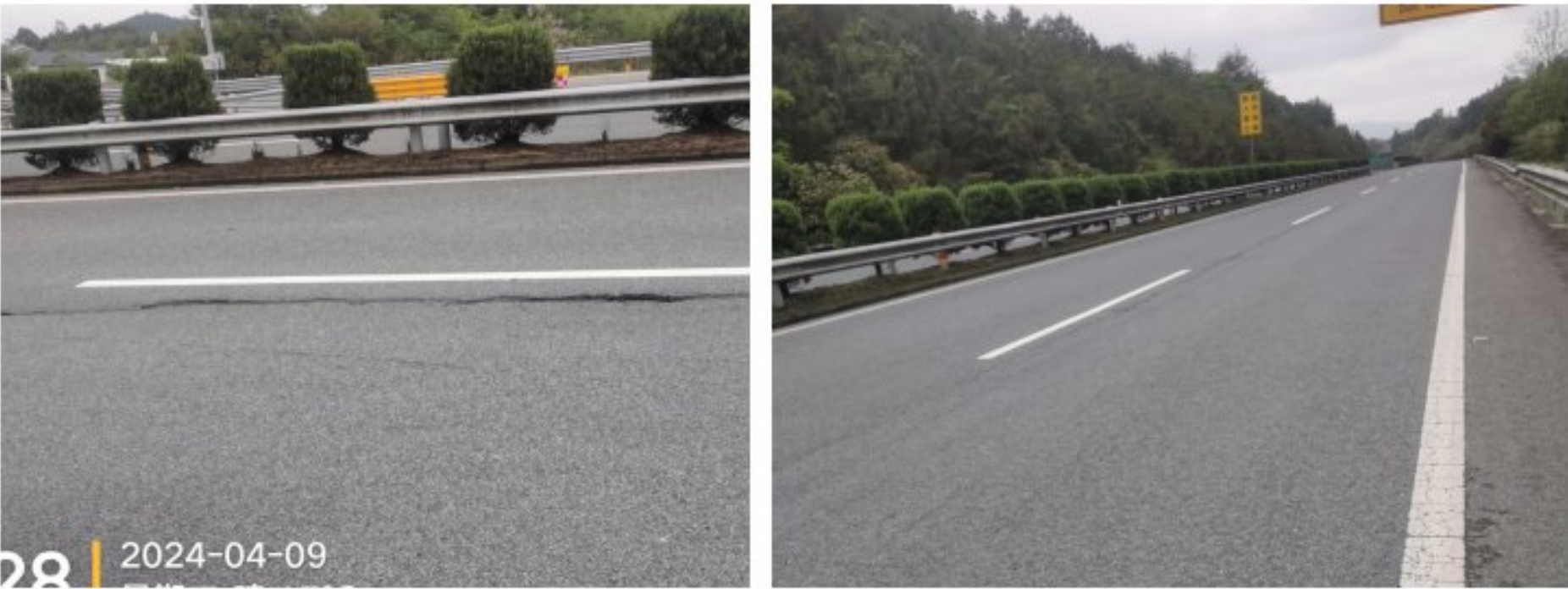
图 4-2：纵向裂缝
